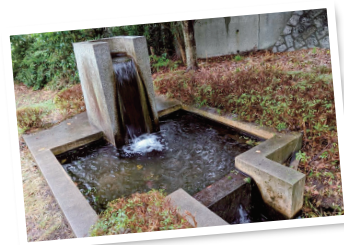
▲「井原第二公園まちなかビオトープ」 地下水を汲み上げて利用しています。
